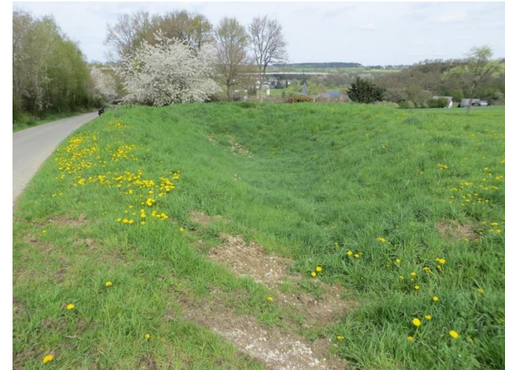
dezentraler Rückhalt (hier: Bsp. Erdbecken)
